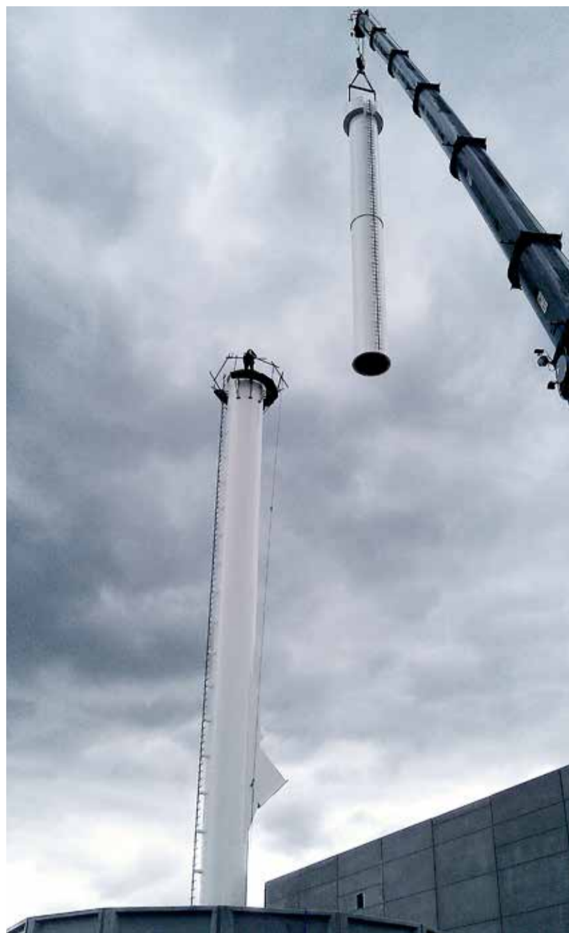
Den 50 meter høje stålskorsten er nu på plads i Holsted. Foto: DC.
