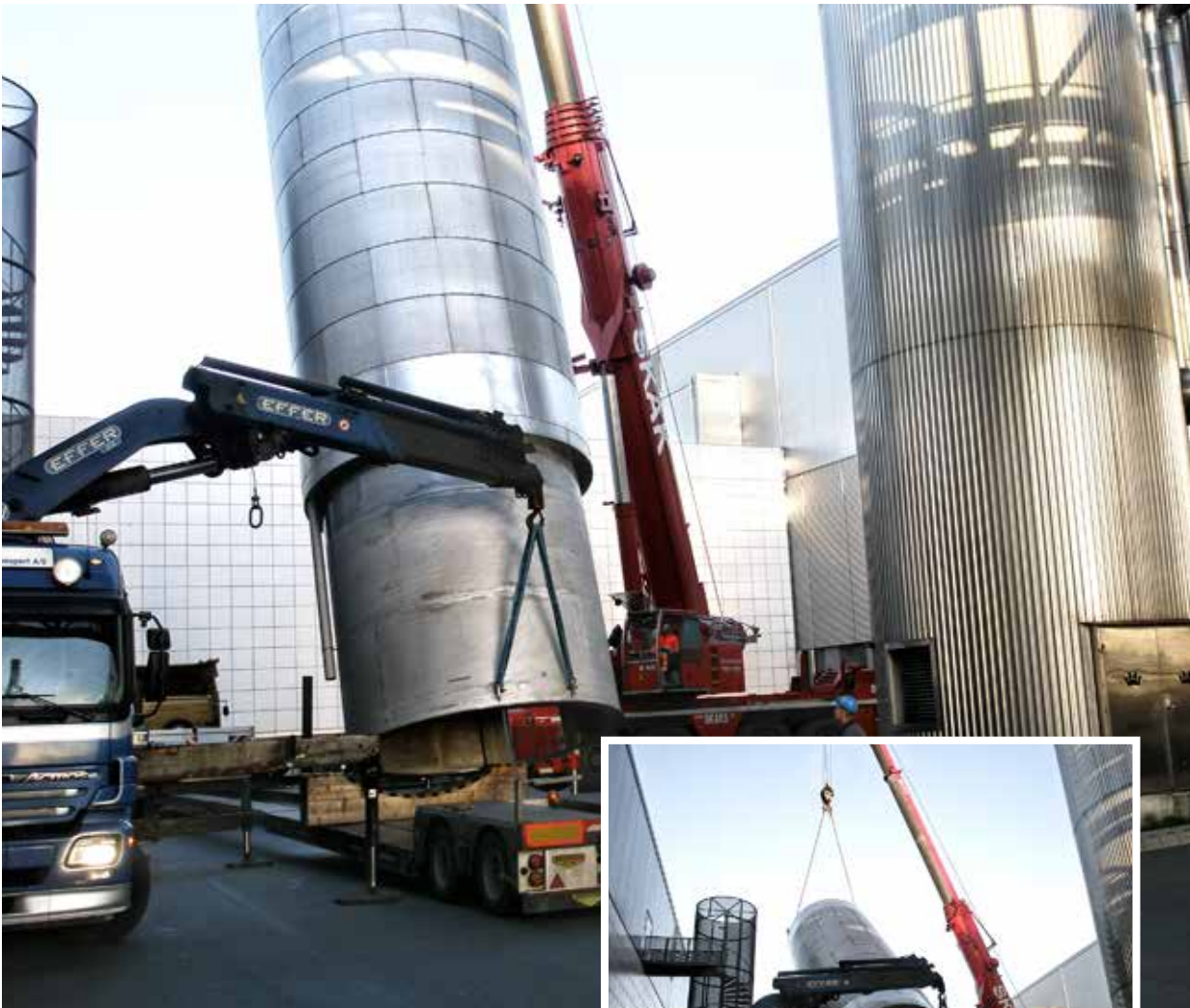
Rengøringstankene rager godt op med deres højde på 15 meter. De genbruger varmen fra slagteproduktionen. Foto: DC.
