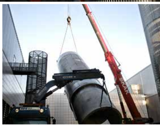
Rengøringstankene rager godt op med deres højde på 15 meter. De genbruger varmen fra slagteproduktionen. Foto: DC.
